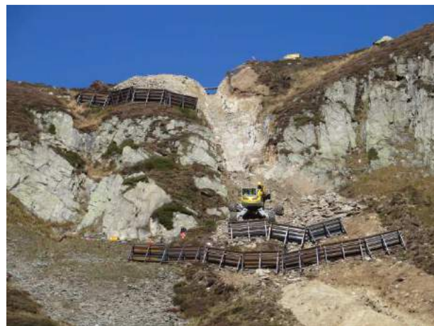
Für die Verlegung der Rohre wurde eine markante Schneise in den Felsen gesprengt
