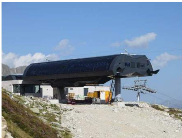
Bergstation Sesselbahn Unterstafel – Gütsch
