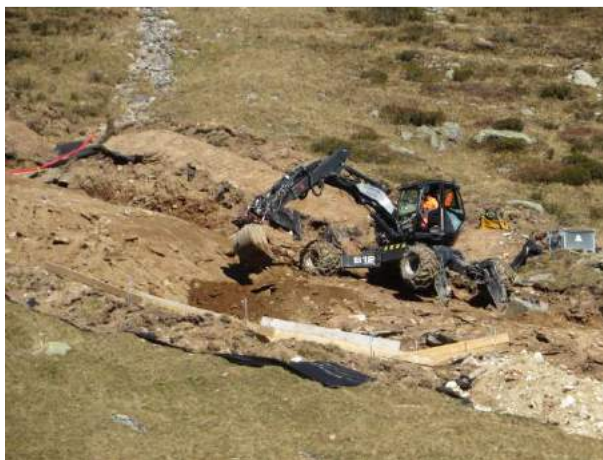
Baumaschinen zum Verlegen der Wasserleitungen
