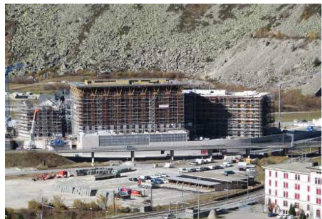
Am 18.10.17 ist die Dachkonstruktion montiert
