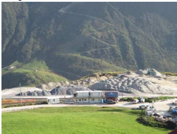
Container und Erdhügel auf der Baustelle
