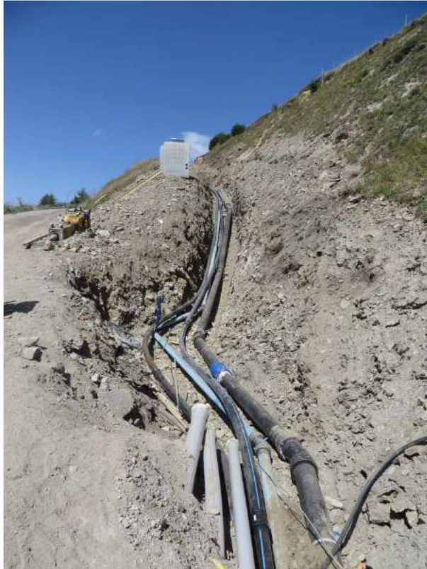
Offene Gräben und diverse Leitungen
