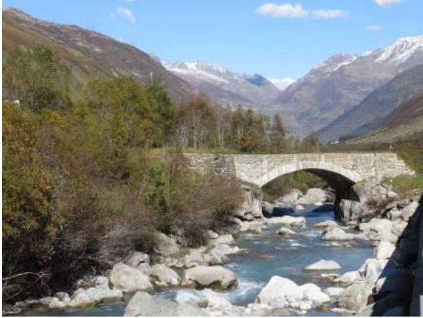
Steinerne Bogenbrücke über die Furkareuss
