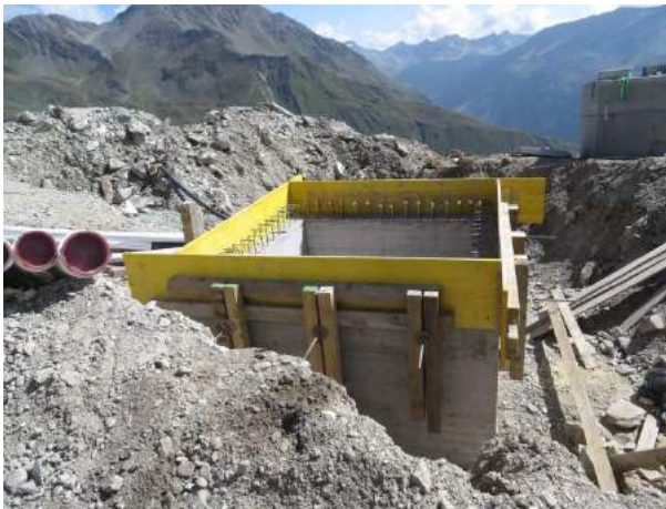
Betonieren eines Sockels im Gebirge
