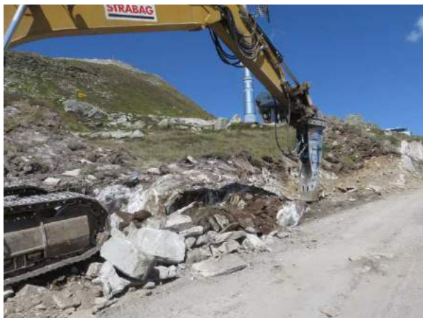
Baumaschine unterhalb dem Stöckli im Einsatz
