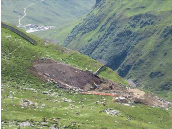
Baubeginn der Gondelbahnanlage am 19.07.17
