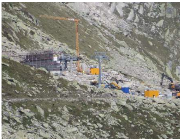
Bau der Bergstation Strahlwand
