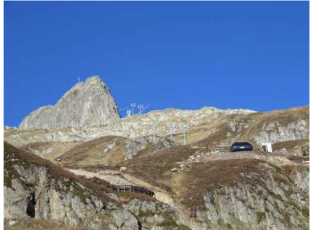
Liftnlage Gondelbahn Vordere Felli - Schneehüenerstock
