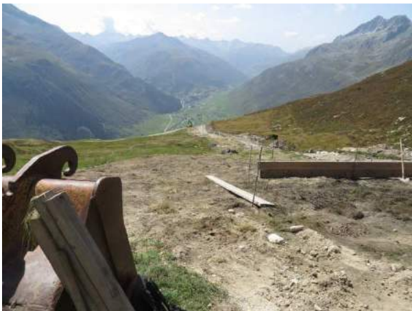
Erdarbeiten für die Piste Nätschen – Gütsch
