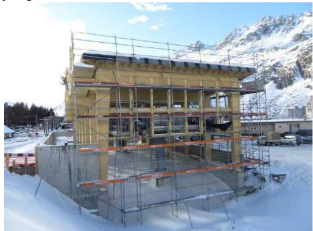
Bau der neuen Talstation Andermatt - Nättschen
