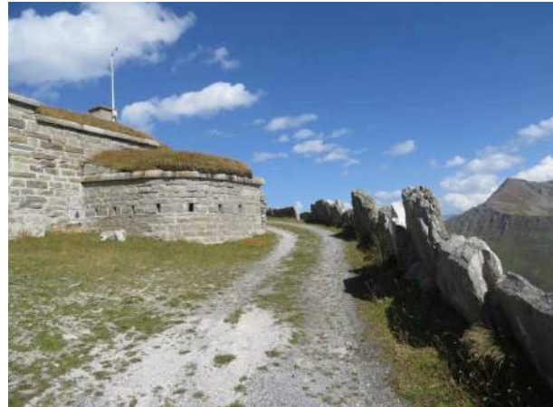
Kaponniere, ein massiv gemauerten Gang oder Raum, aus dem die Verteidiger schiessen können
