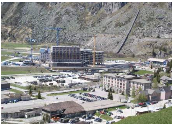
Das Radisson Blu im Rohbau am 16.5.2017
