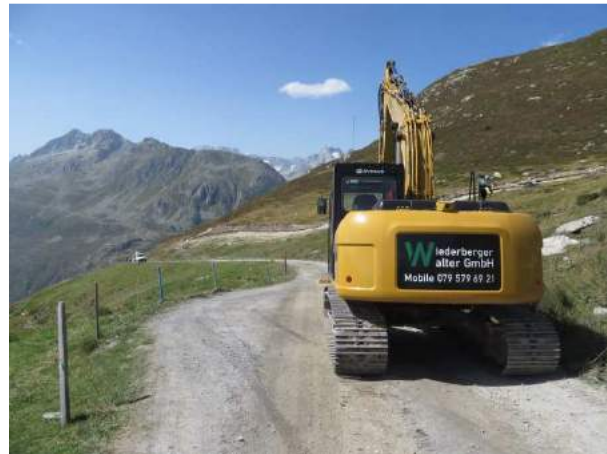
Bagger und Transporter auf der Gütschstrasse
