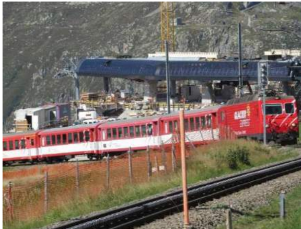
Neue Mittelstation der Achtergondelbahn beim Bahnhof Nätschen
