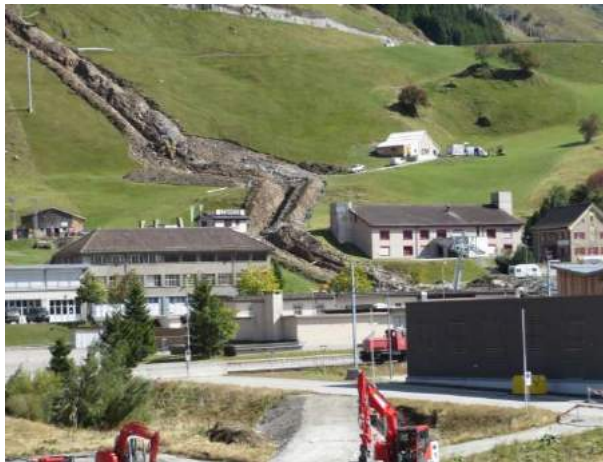
Leitungsbau Andermatt – Nätschen
