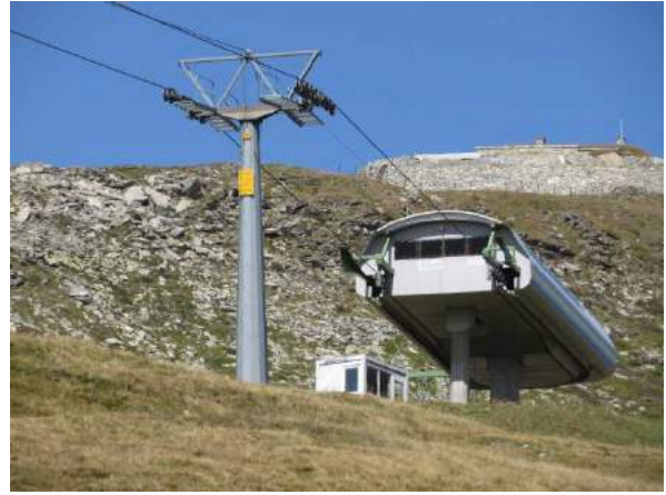
Bergstation Stöckli unterhalb des historischen militärischen Forts
