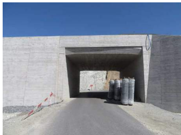
Neue Unterführung Nättschen für die Strasse auf den Gütsch und für die Skipiste
