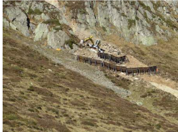
Bauarbeiten für die Wasserzufuhr der Beschneigungsanlagen vom Oberalpsee her
