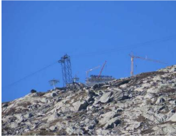
Bau der Bergstation Schneehüenerstock
