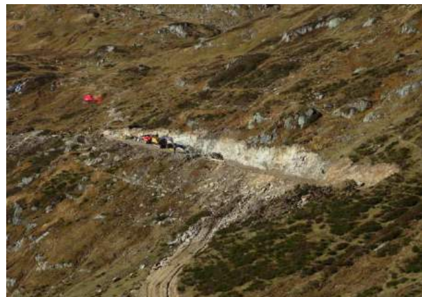
Pistenbau in der Hinteren Felli
