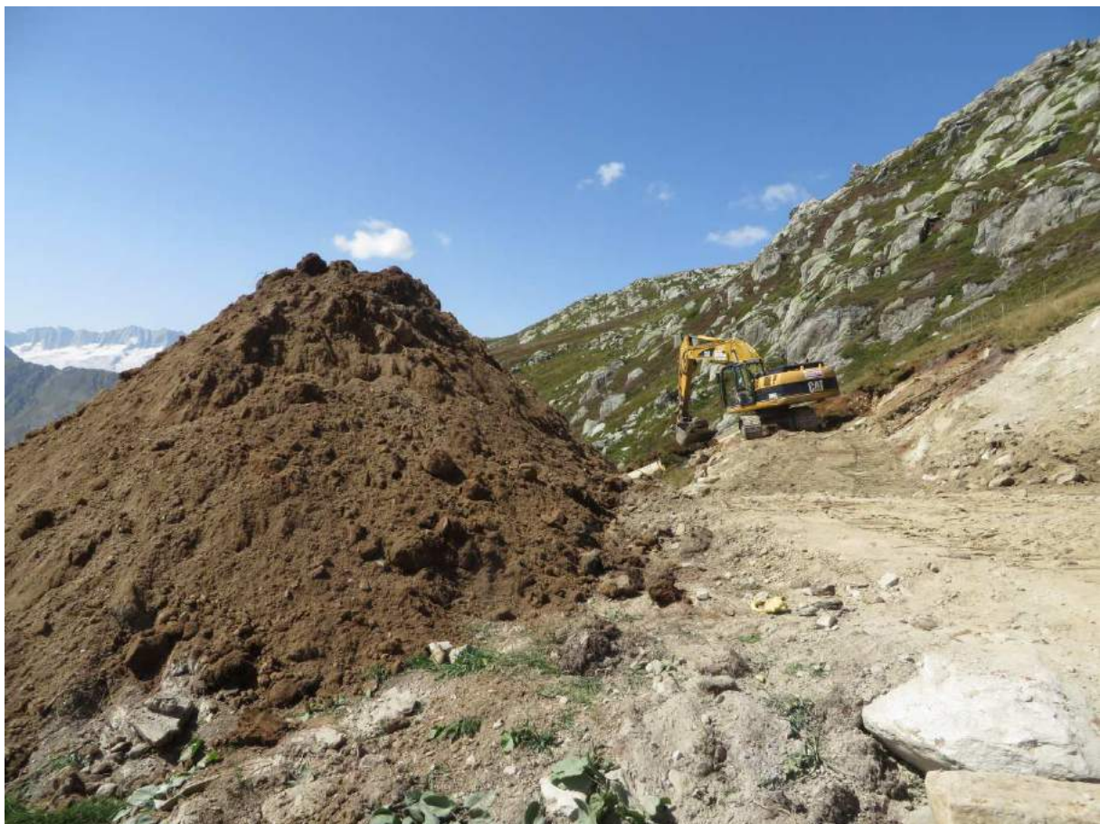
Pistenbau Nätschen – Gütsch am 26. August 2017
