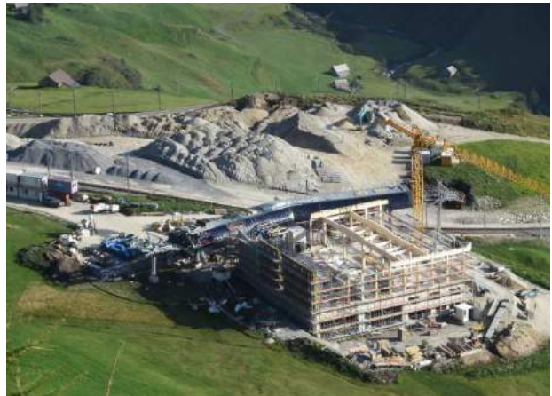
Bei der Mittelstation Nätschen entsteht auch ein neues Restaurant
