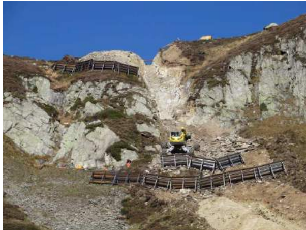
Schneise für Beschneigungsanlagen beim Oberalensee
