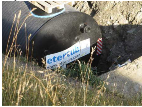
Aufbereitung von Trinkwasser oberhalb Nättschen
