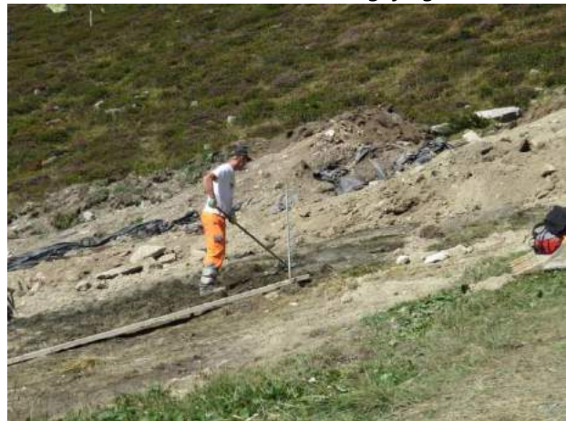
Abgetragene Grasmatten werden wieder verlegt
