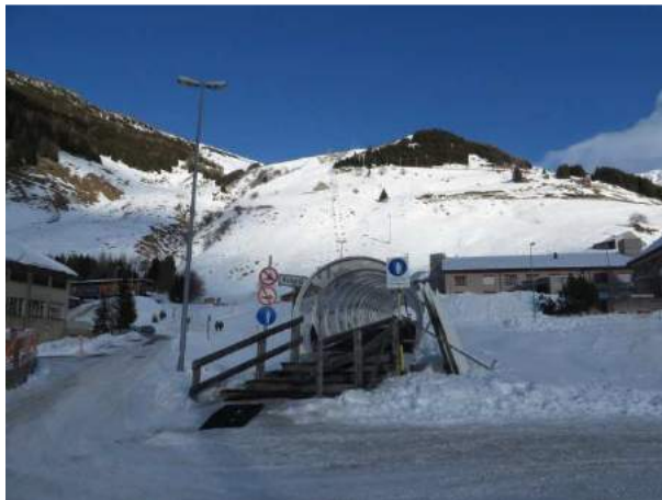
Bereits abmontierte Sesselliftanlage Andermatt - Nättschen
