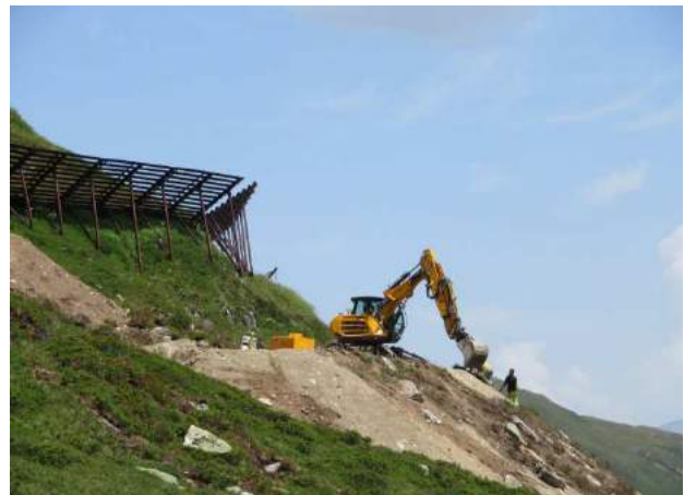
Bau der Talstation Vordere Felli
