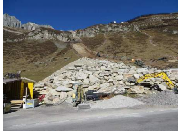
Pumpstation und Wasserleitungen
