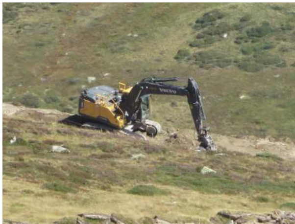
Leitungen werden verlegt
