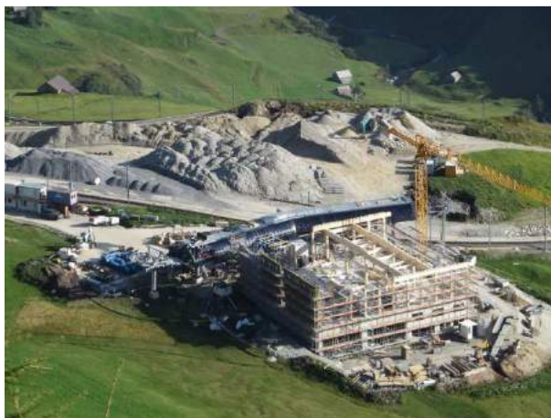
Mittelstation der Gondelbahn im Bau
