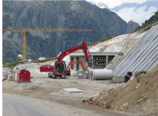
Baustelle Bahnhof Nättschen
