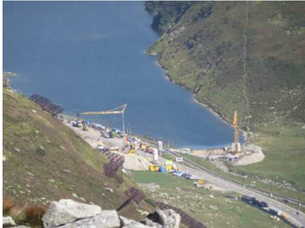
Bau der Pumpstation am Oberalpsee
