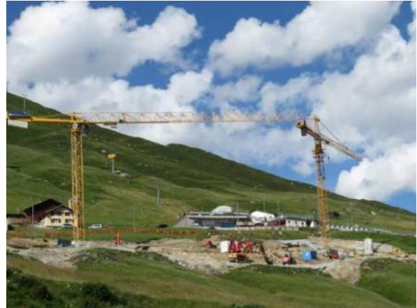
Baustelle Plattform und Bergstation Näschen (18.07.2016)
