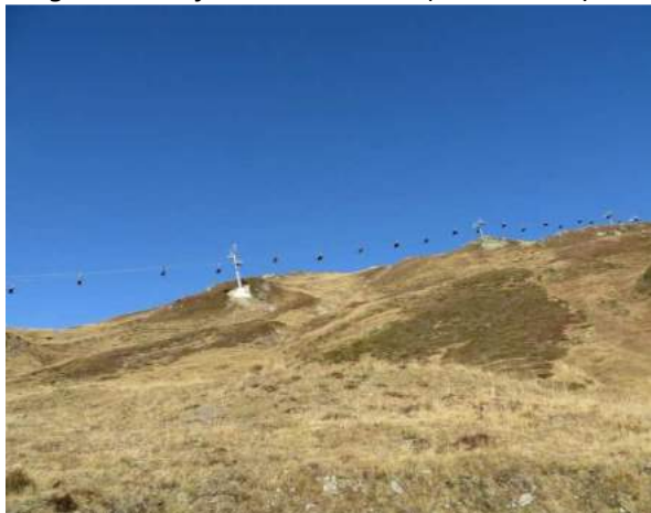
Die neuen Sechsessel Oberalp – Calmot während einer Testfahrt (31.10.2016)
