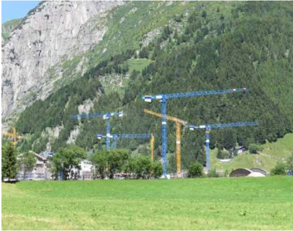
Bau des Resorts (19.07.2016)
