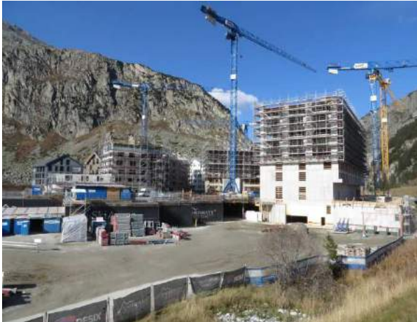
Appartementshäuser, Hotel Radisson Blu und Gotthard-Residences-Gebäude im Bau (v.l.n.r.)
