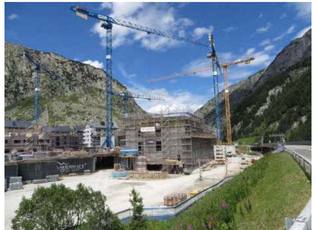
Bau des Resorts (03.08.2016)
