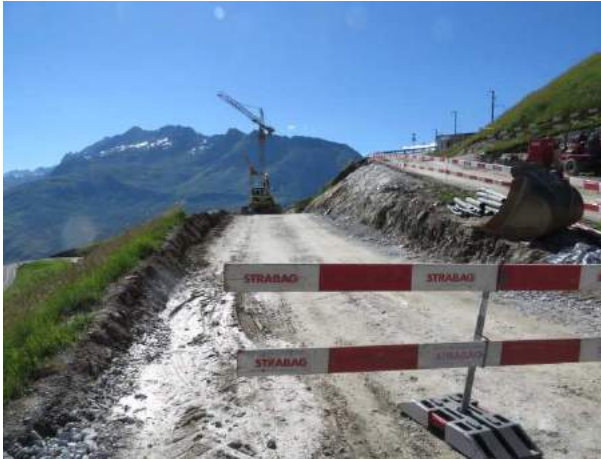
Baustellenzufahrt beim Bahnhof Nättschen
