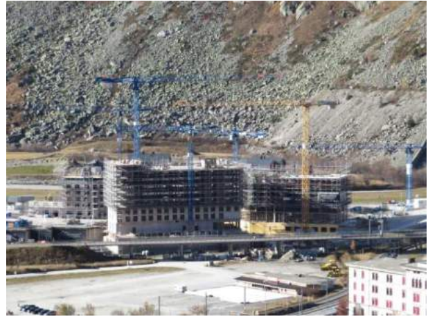
Bau des neuen 4-Sterne-Hotels mit 180 Betten und mehreren Konferenzräumen (31.10.2016)
