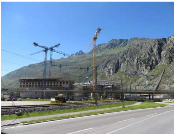
Bau des Resorts (25.08.2016)
