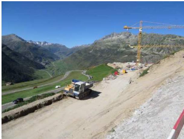
Bau der Halle für den Wintereinstand der Gondeln
