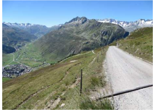
Strasse Gütsch-Nättschen, Blick Richtung Andermatt mit Furkapass, Böz und Dammakette
