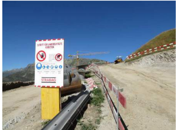
Grossbaustelle Bahnhof Naetschen
