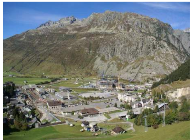
Bau des Resorts (29.09.2016)
