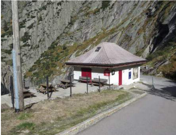
Das Restaurant Teufelsbrücke in der Schöllenen-schlucht
