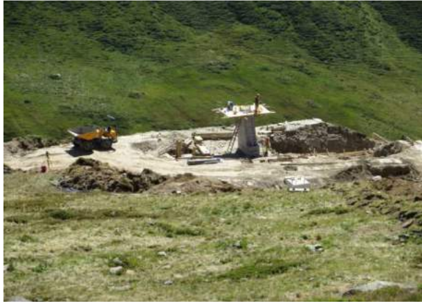
Bau der Talstation Sechssersesselbahn Unterstafel – Gütsch (25.08.2016)
