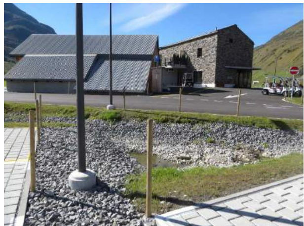
Sickermulde beim Club House Parkplatz
