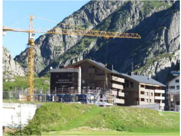
Bau des Resorts (19.07.2016)
