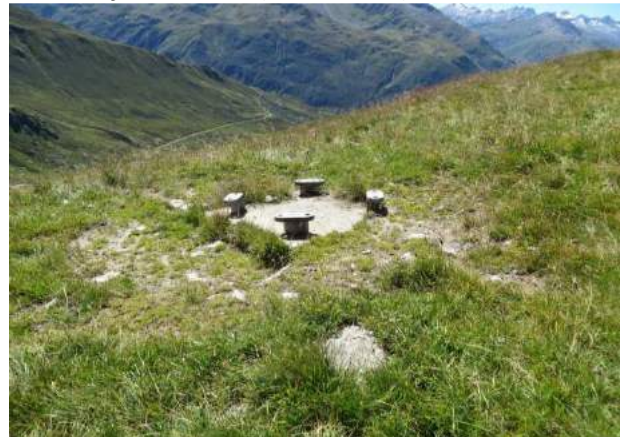
Verankerungen für die Liftstützen bei Unterstafel
