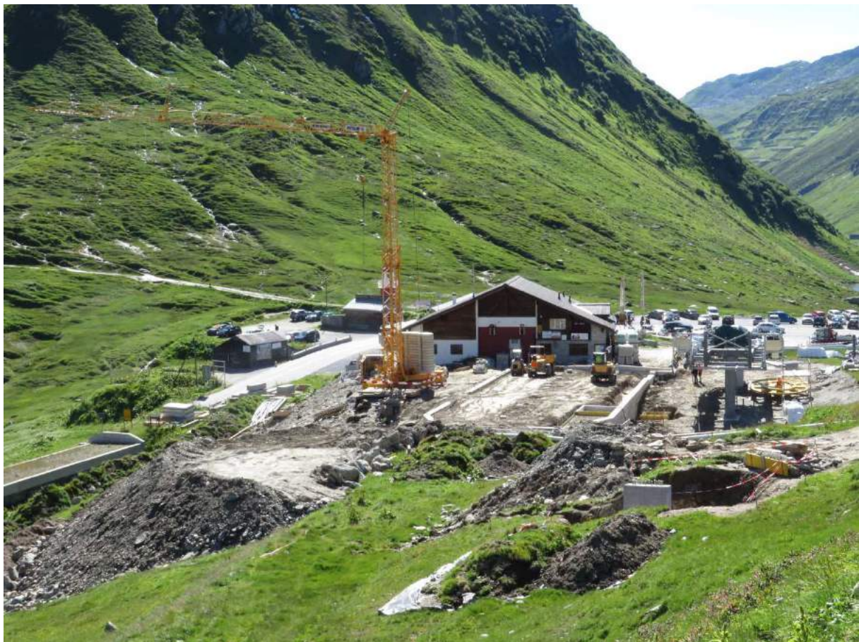
Baustelle Talstation Sessellift Oberalppass – Calmot am 17. Juli 2016
