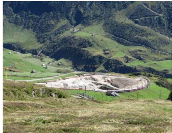
Grossbaustelle der Zwischenstation beim Bahnhof Näschen (23.08.2016)
