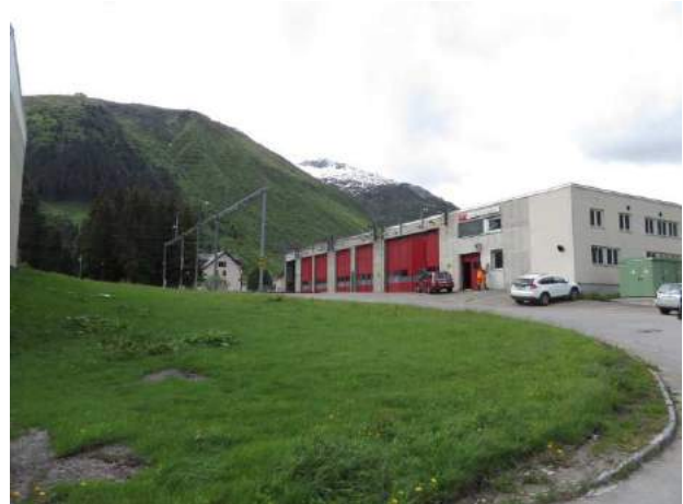
Bestehendes Bahndepot der MGB in Andermatt
