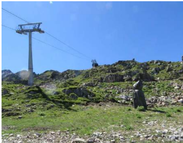
Sechsesselbahn Gurschen – Gurschengrat mit eingepackter Lanzette als Beschneigungsanlage
