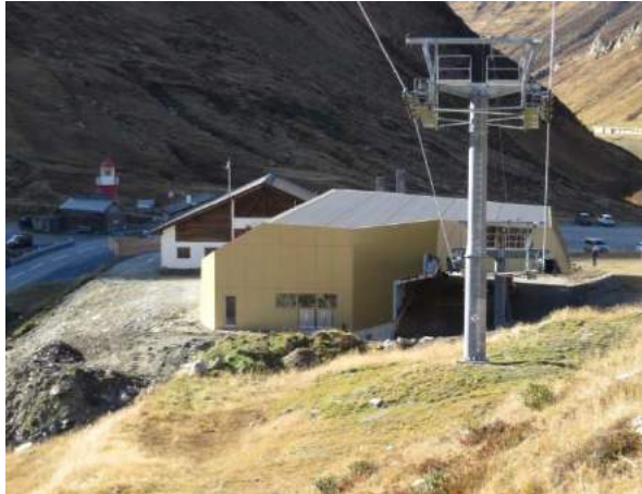
Neue Talstation der Sesselbahn Oberalp – Calmot oder Alpsu – Calmut (31.10.2016)
