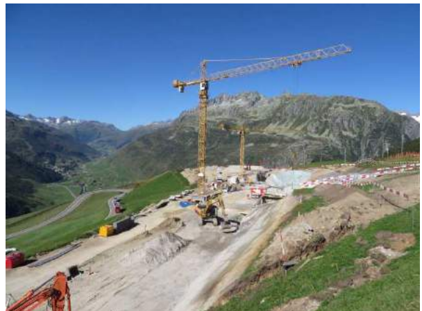
Erdarbeiten beim Bahnhof Naetschen (25.08.2016)
