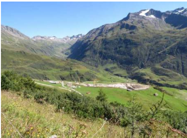
Grossbaustelle Bahnhof Naetschen (23.08.2016)
